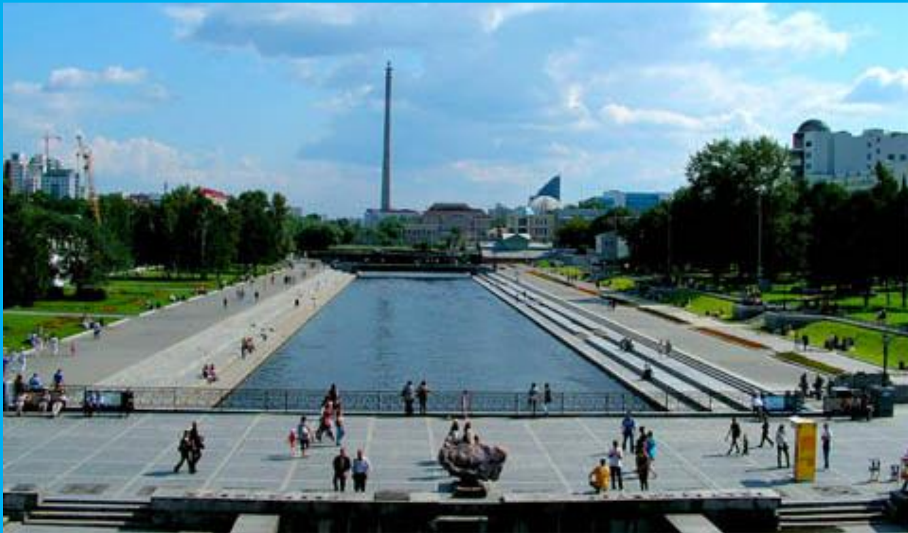
Плотина Городского пруда на рекé Исётъ
